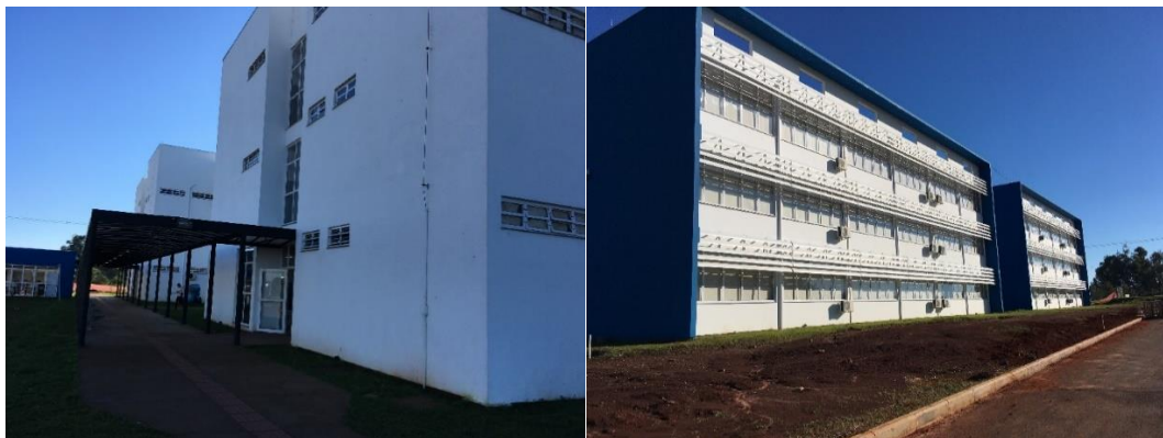
Figura 3 –Fotografia fachada norte à direita e sul à esquerda
