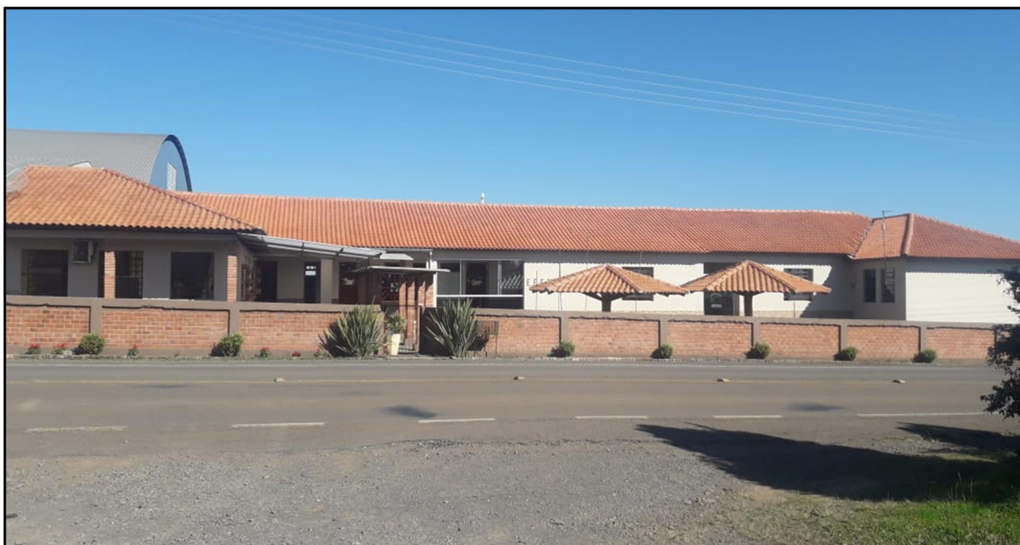
Figura 2 - Escola Estadual de Ensino Fundamental Dom Érico Ferrari
