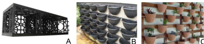
Figura 5 - Sistemas modulares de paredes vivas: (A) módulos de tabuleiros; (B) parede viva de vasos com estrutura de aço galvanizado; (C) vasos fixados em madeira
